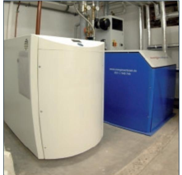
90% bewirkt, dass bis zu 40% Primärenergie eingespart werden kann. Gerade ein Hallenbad mit einem konstant hohen Wärmebedarf (Wasser, Halle) ist für den Einsatz eines BHKW prädestiniert.
